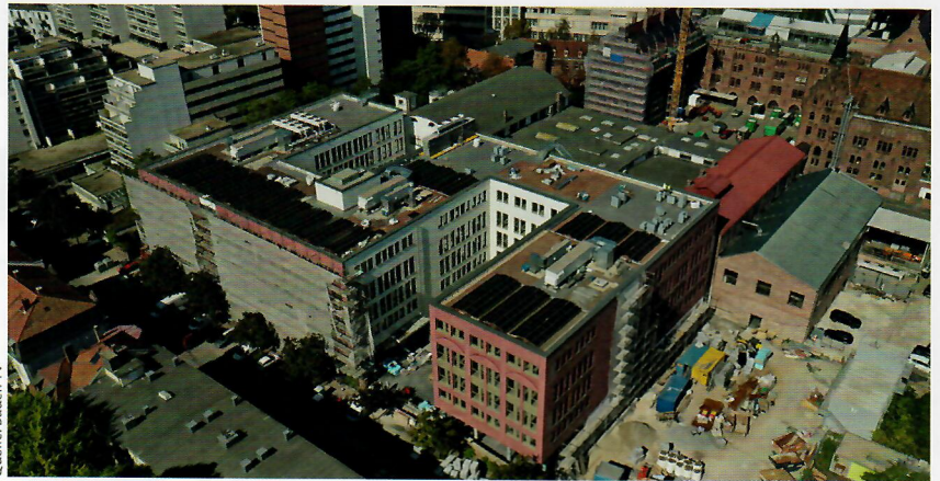
PV-Anlagen auf dem iWerkx im Smart-East-Areal
